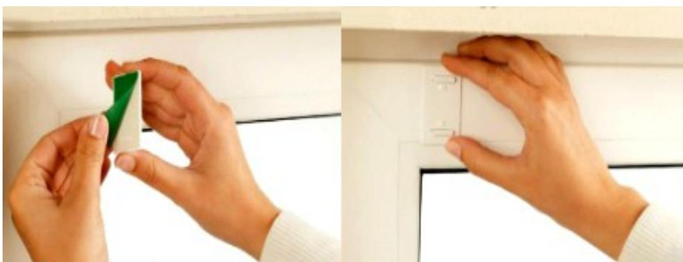
Рис. 2. Пример крепления жалюзи на двухсторонний скотч
